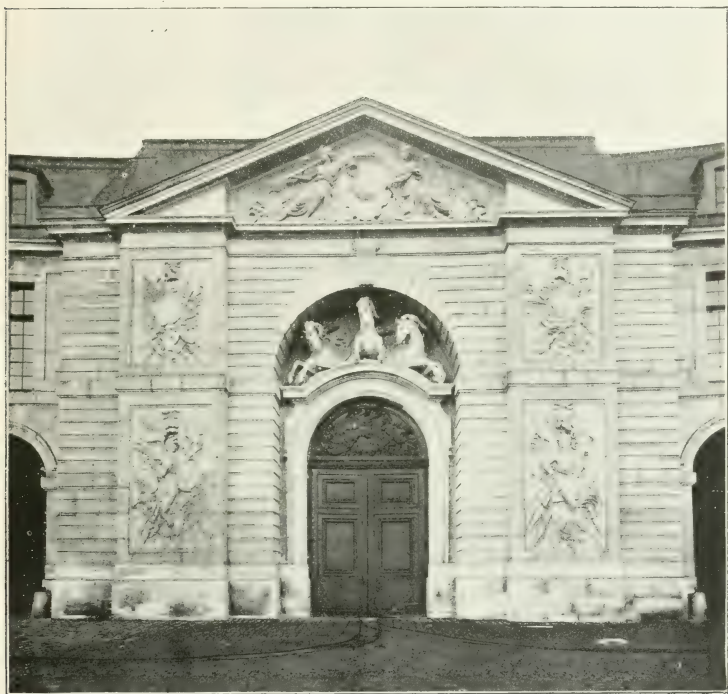
Avant-corps central de la Grande-Écurie.
